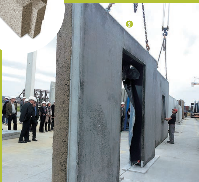
(1) BLOC DE BÉTON DE CHANVRE À EMBOÎTEMENT (2) PANNEAU DE BÉTON DE CHANVRE NÉOCHANVRE – ENTREPRISE MNBC
