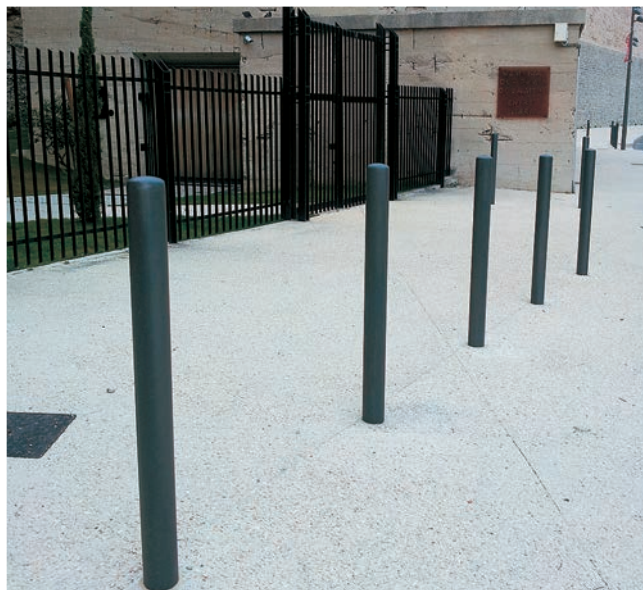
SCELLEMENTS DE POTEAUX
