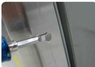
31. Remontez les poignées de l'autre côté des portes en suivant la procédure inverse.
