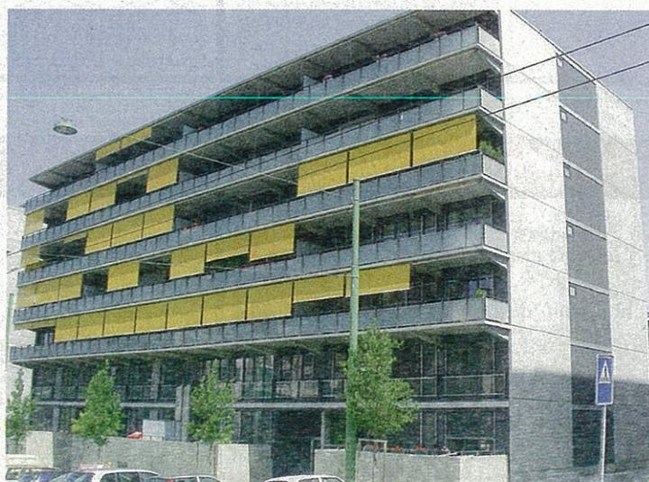
entre la consommation de chauffage prévue (53 MJ/m<sup>2</sup>/an) et mesurée (130 MJ/m<sup>2</sup>/an). Deux catégories d'effets sont à l'origine des écarts observés : les uns concernent la performance intrinsèque des bâtiments, les autres sont liés à leurs conditions d'utilisation, c'est-à-dire au comportement des habitants.
