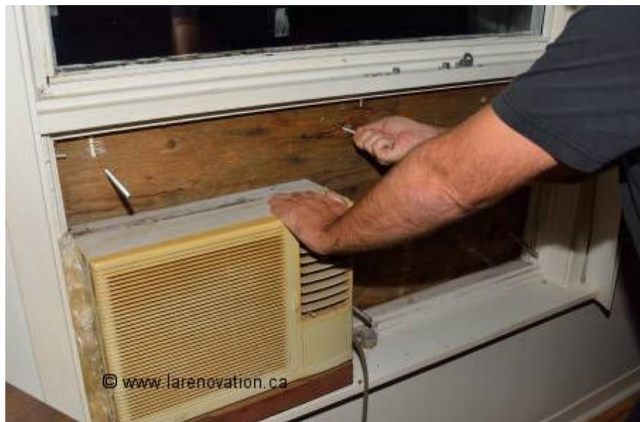
Selon l'épaisseur du contour du châssis, on ajoute une pièce de bois de la même épaisseur sur un des panneaux, pour empêcher que le contreplaqué ne courbe lorsqu'on serre les boulons. Pour améliorer l'isolation entre les panneaux, on peut y mettre de [la laine de verre](#) ou découper un panneau d'isolant rigide qu'on colle sur l'un d'eux.
