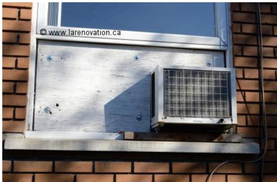
Comme les panneaux sont coupés sur mesure, et qu'il n'y a que quelques écrous à serrer, la pose du climatiseur devient une question de minutes. Si on fixe les boulons au panneau extérieur, on a même plus besoin d'aller à l'extérieur pour faire l'installation, il suffit de passer le panneau par l'ouverture pour le mettre en place.
