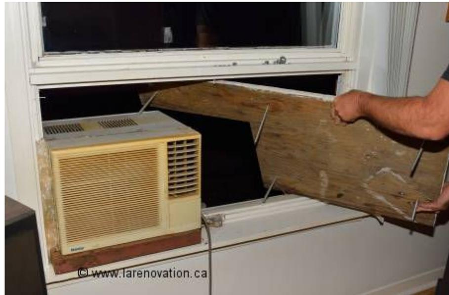
L'année suivante, pour faire l'installation du climatiseur, il suffit d'enlever le châssis de la fenêtre, fixer le climatiseur, mettre les deux panneaux en place, visser les écrous avec une clé, et voilà. Pour améliorer l'étanchéité des joints qui longent le climatiseur d'air, on peut mettre un [ruban adhésif](#) de mousse sur le rebord des panneaux, ce qui va compresser la mousse contre l'appareil.
