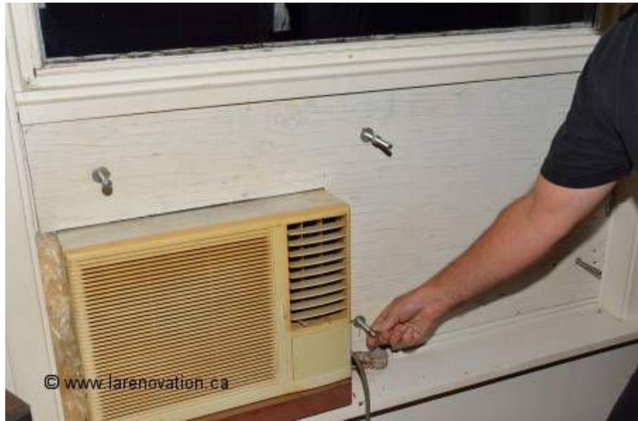
Pour s'assurer que le boulon ne peut pas être dévissé par l'extérieur, on utilise des boulons à tête ronde. On passe le boulon par l'extérieur, et on le visse avec un écrou à l'intérieur. Une fois bien serré en place avec une clé, il est impossible de les dévisser par l'extérieur.
