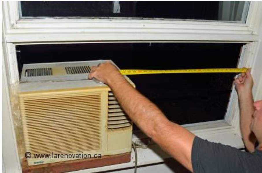
On place donc le climatiseur en place, et avec un [ruban à mesurer](#), on prend les dimensions pour tailler les deux panneaux sur mesure. Comme il est probable que la dimension des panneaux soit différente, on aligne le coin formé par le climatiseur, pour ensuite utiliser une [perceuse électrique](#) pour percer les trous où on va passer [les boulons](#).
