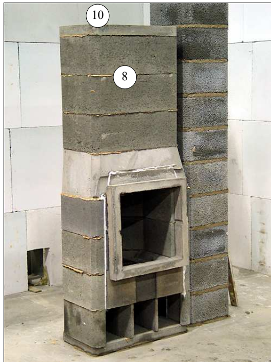
12. Levitä laasti ja asenna seuraavat 2 kpl ulomman vaipan rengaselementtiä n:o 8 ja sisähattuelementti n:o 10 (kansi) paikalleen. Puhdista laastipurseet huolellisesti.
