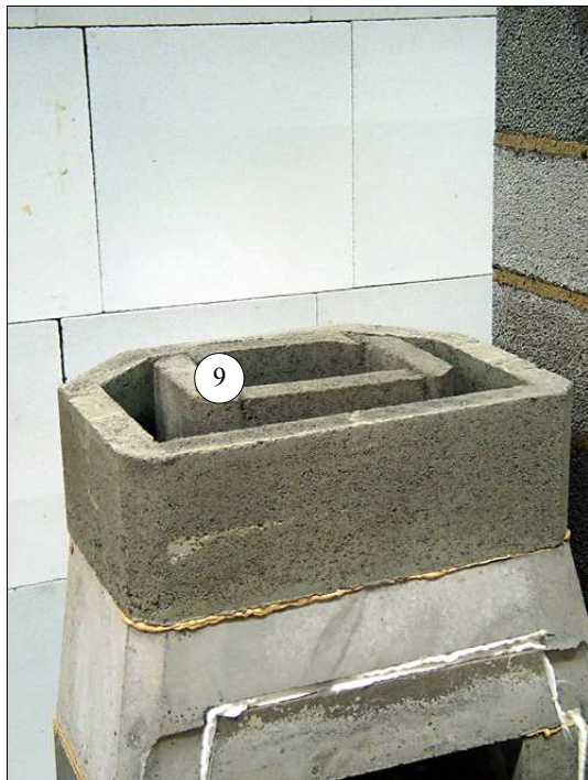
11. Levitä laasti ja asenna tuliputkielementti n:o 9 paikalleen.
