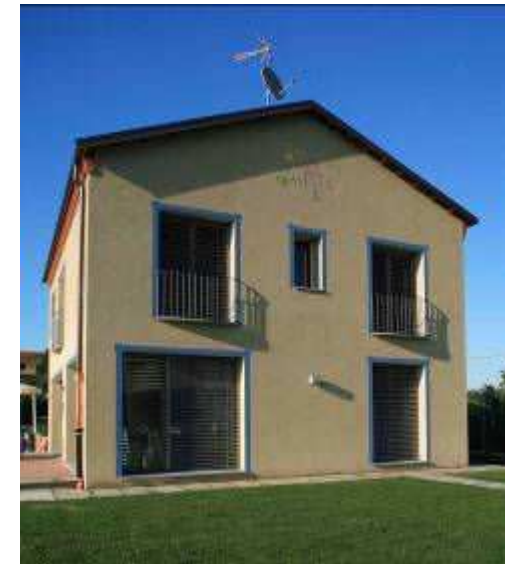
Fig.3. 19 - Passivhaus construite à Cherasco, Cuneo, Italie du nord
