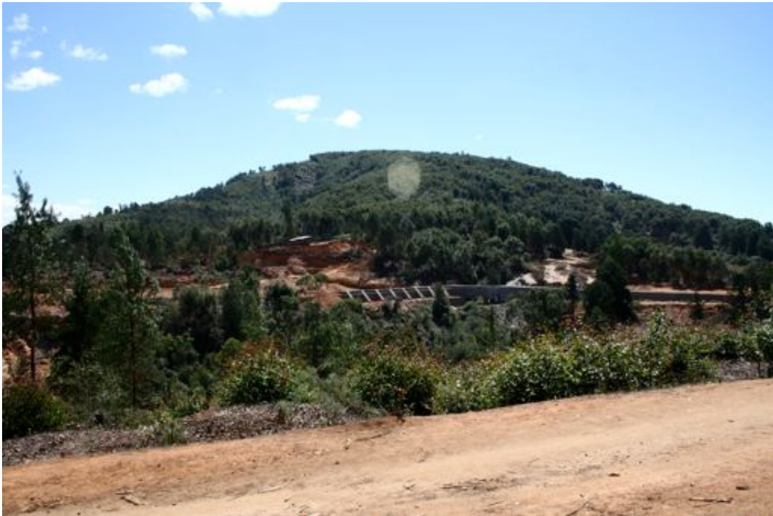
Canal vu de loin
