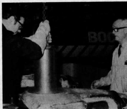
Fig. 6. Assemblage d'un axe de palier de croisillon.
