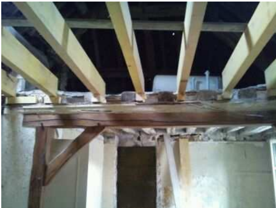
Photo prise le dos à la cheminée en regardant vers le garage
