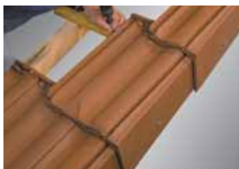
Fixation des tuiles en rive latérale droite par crochet "GM" Réf. CRP02.
