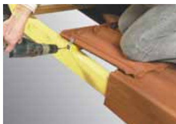
Fixation des tuiles en rive latérale gauche par crochet "GM" Réf. CRP02 rabattu contre l'extrémité du liteau.
