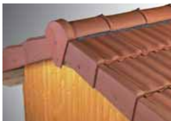
Fixation des rives individuelles et du fronton, par vis et rondelle d'étanchéité.
