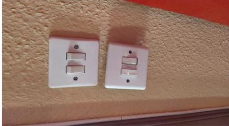
Les doubles interrupteurs ( voir photo) commandent l'un des lustres ( 2 câbles noir et bleu au plafond ) l'autre ( voir photo interrupteur + poussoir câble brun et orange ) commande l'autre lustre ( 3 câbles orange/noir/ et bleu au plafond ) Le poussoir fait office de va et vient pour le couloir donc ne pas en tenir compte ..
