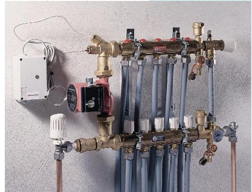
En partant du piquage sur une distribution radiateur, le collecteur-confort R557 permet d'abaisser la température de l'eau.
