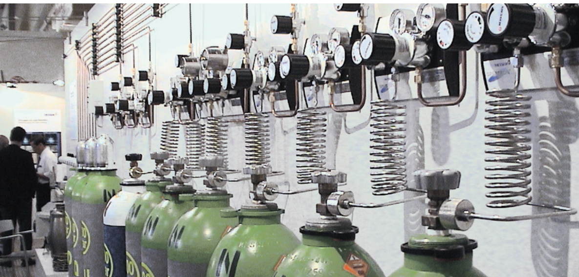
Alimentation en gaz centralisée - la solution de sécurité
