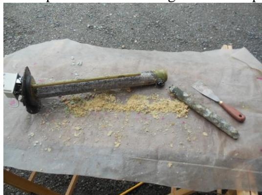
11. Finir de vider la cuve de son eau et de ses résidus de calcaire. Pour cela utiliser l'aspirateur de chantier.
