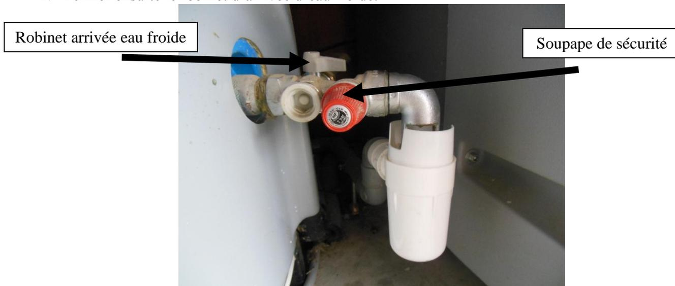
3. Ouvrir ensuite plusieurs robinets d'eau chaude (afin de diminuer la pression) et ouvrir la soupape de sécurité 7b (rouge sur la photo).
