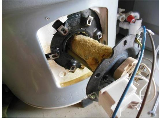
8. Sortir le corps de chauffe en le tirant horizontalement puis le basculer vers le haut pour sortir l'anode.
