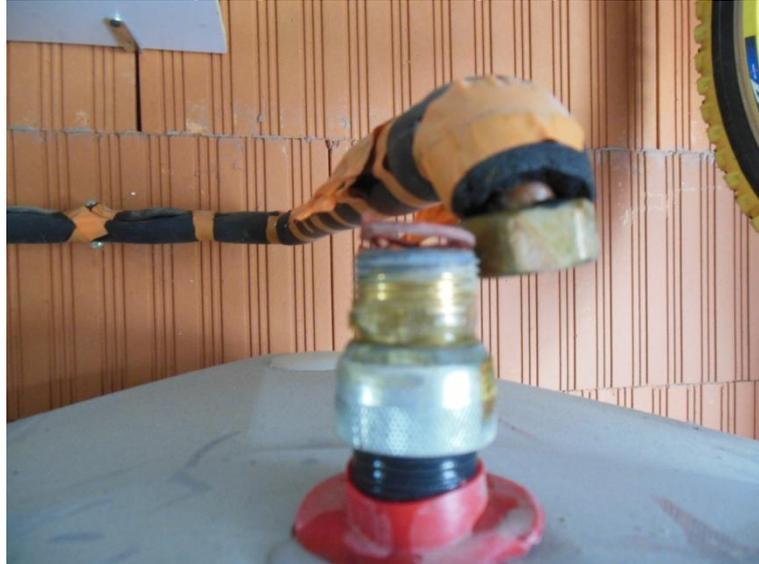
19. Ouvrir un robinet sur l'eau chaude, fermer la soupape de sécurité (rouge, ¼ de tour) puis ouvrir l'arrivée d'eau froide.
