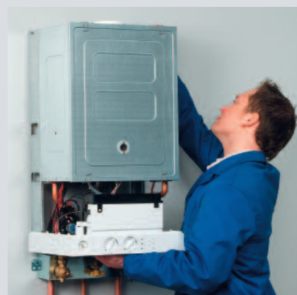
2 Montage de la chaudière
