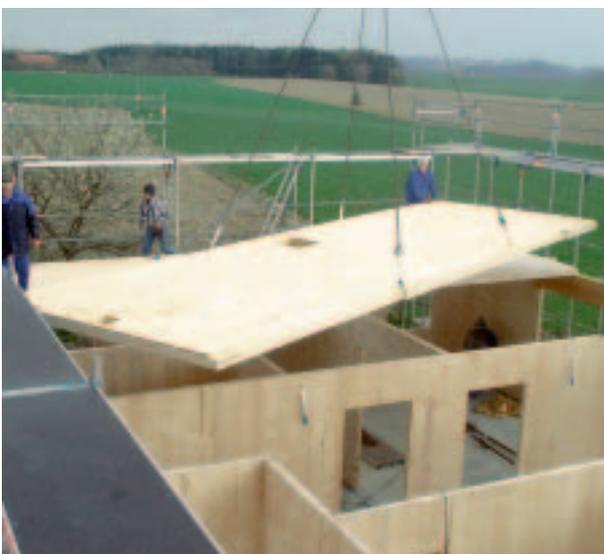
*Montage de plancher, construction par murs à hauteur d'étage*
