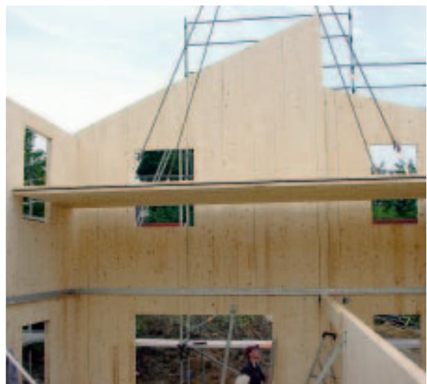
*Montage de plancher, construction par murs à hauteur de bâtiment*
