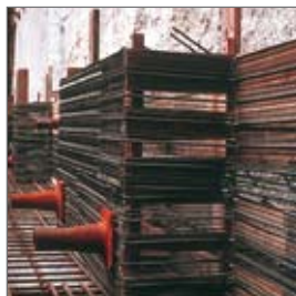
Reprise de bétonnage Concrete joint
