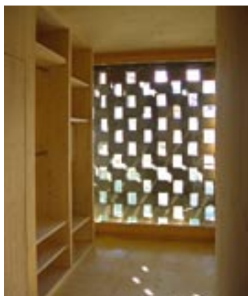
Un "mur" constitué d'armoires sert de porteur intermédiaire (ici le hall d'entrée).
