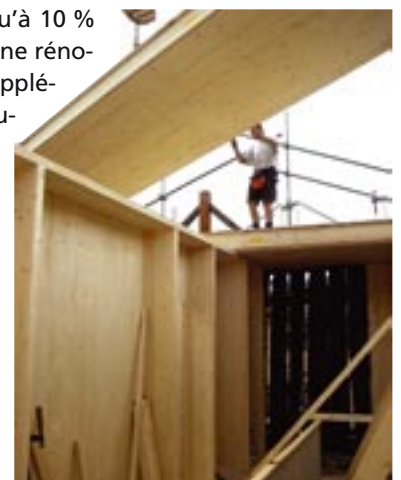
Montage des éléments en panneaux trois plis de sapin à l'aide d'un camion-grue.
