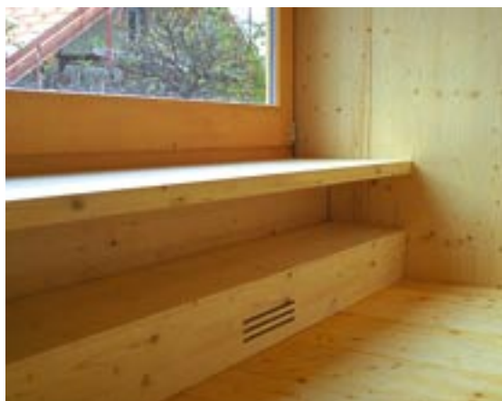
L'air frais est pulsé à travers des ouvertures discrètes pratiquées dans les panneaux trois plis en sapin.
