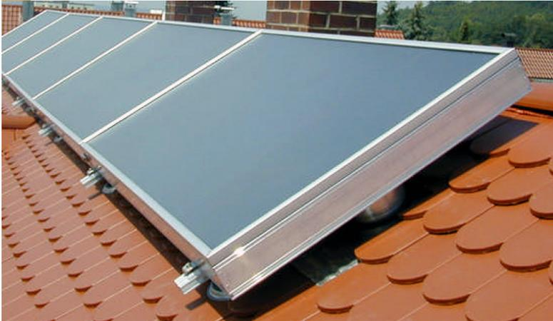
Les systèmes TwinSolar et TopSolar sont si simples qu'ils permettent l'installation de chauffage et ventilation solaires dans pratiquement n'importe quel bâtiment sans modifier le système de chauffage traditionnel. Ils peuvent être implantés sur toute surface extérieure : toits en pente, toits plats, murs verticaux, en intégration ou sur guides de support.
