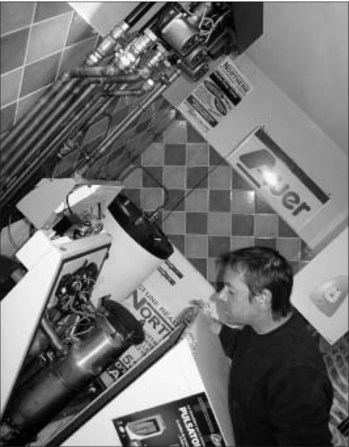
A la tête de Northerm, Alain Sinaeve mise sur la chaudière à combustion pulsatoire.
