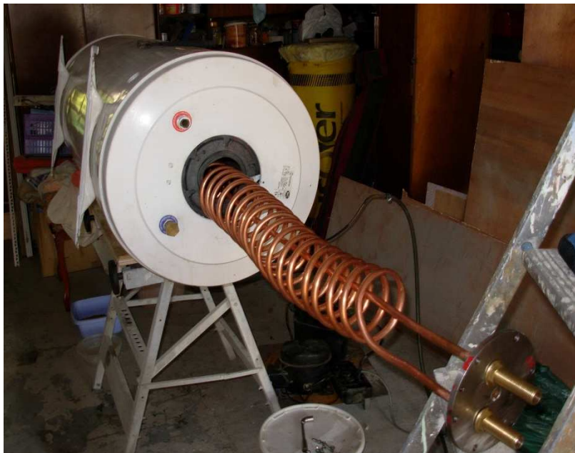
mise en place du serpentin
