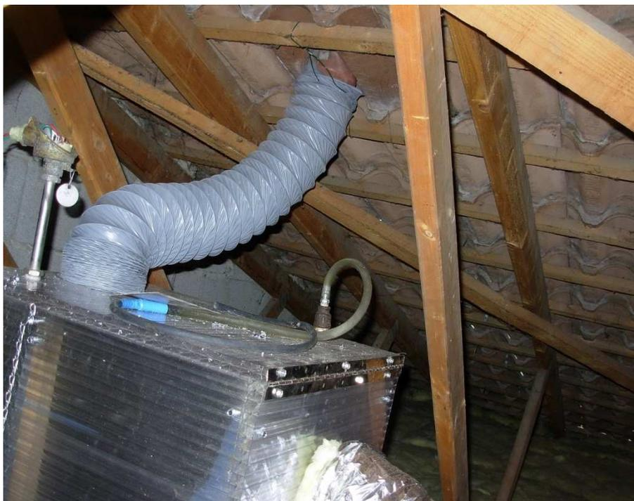
le caisson en place dans les combles on aperçoit le tuyau de dégazage afin de remplir au mieux le circuit fermé qui est sous pression avec un fexcon à 1.5 b
