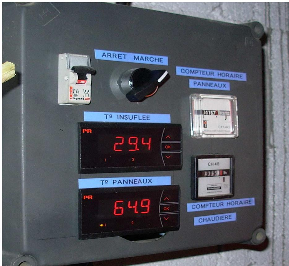
Le panneau de contrôle des panneaux solaires ,ne tenez pas compte de la T° insuflée ( c'est une t° pour le fonctionnement en hiver dans la maison le système est déconnecté l'été la réalisation d'un T équipé d'une vanne électrique est en cours pour éviter d'aller dans les combles. Eté sur le cesi hiver sur la chauffage maison.
