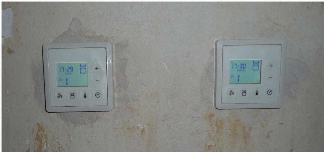
Le menu est très confus au départ, puisqu'il n'est composé que de chiffres. Le relevé de température est par exemple 44 (temp extérieure) 45 (temp insufflation), 46 (temp reprise) et 47 (temp rejetée). Bon c'est pas si grave, mais au début....
