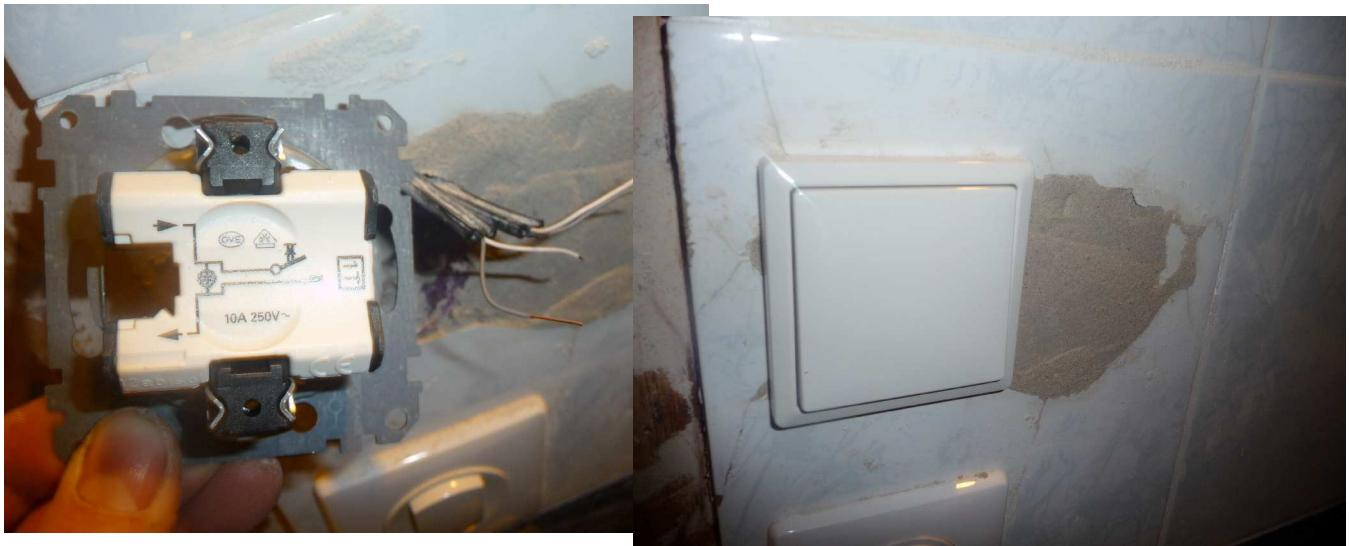
Les Ccease ont besoin de 4 connexions. J'ai utilisé du câble ethernet (FTP cat 5). Il faut croiser le Tx et le Rx (récepteur et émetteur). C'est très simple, et pour une fois, il y a une notice claire. Attention, ces petits boîtiers sont fragiles. J'ai même coupé un fil en ré-empoignant la partie écran. Il a fallu ressoudre. Autre point négatif, les boutons sont peu sensibles, et il est parfois difficile d'accéder aux menus avancés (il faut appuyer sur deux touches en même temps).
