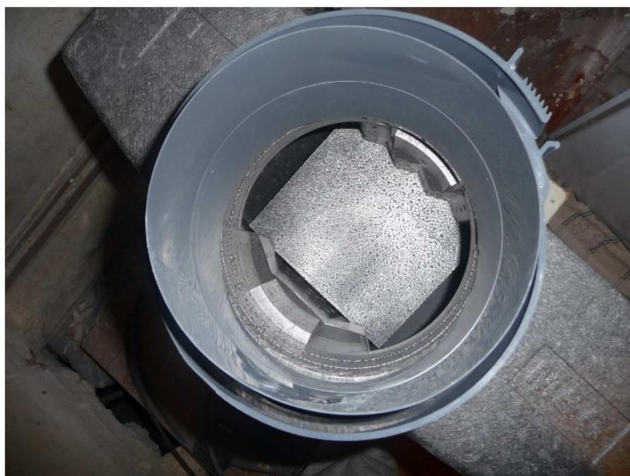
*Il a fallu que je bidouille en coupant le koppelstuck sur les côtés :*
