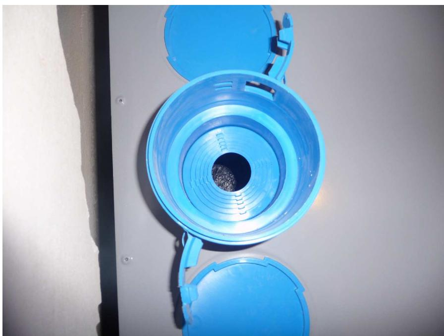
*Pour connecter aux bouches les conduits, il faut un raccord spécial.*
