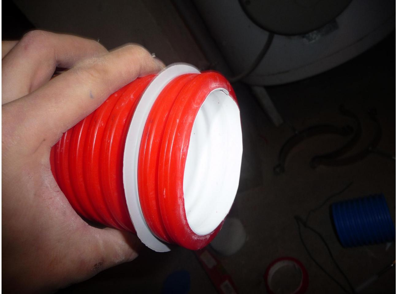
*On met un joint qui s'insère entre les anneaux extérieurs, et qui assure de l'étanchéité pour les raccords aux plenums, aux coude etc... Je n'ai jamais su s'il fallait le mettre au premier ou au deuxième anneau...*
