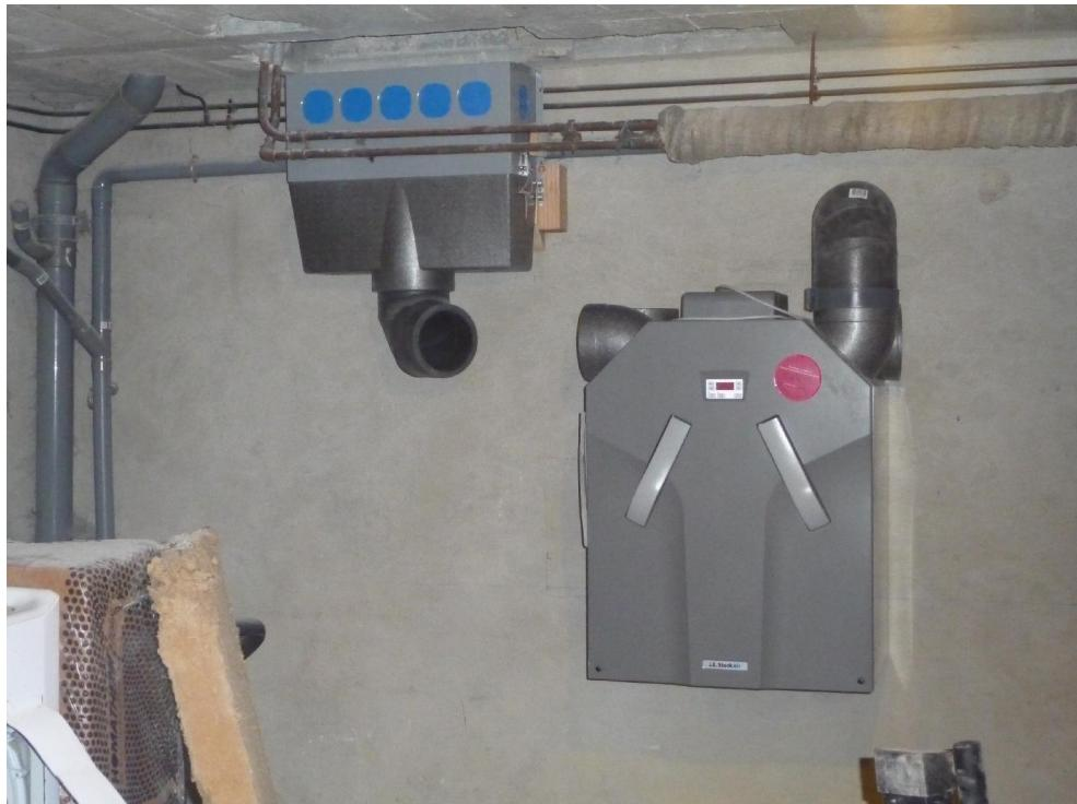
Il faut si possible avoir une sortie des eaux usées pour raccorder la vmc, avec un siphon, et le tout de manière étanche. C'est en DN32, très standard.
