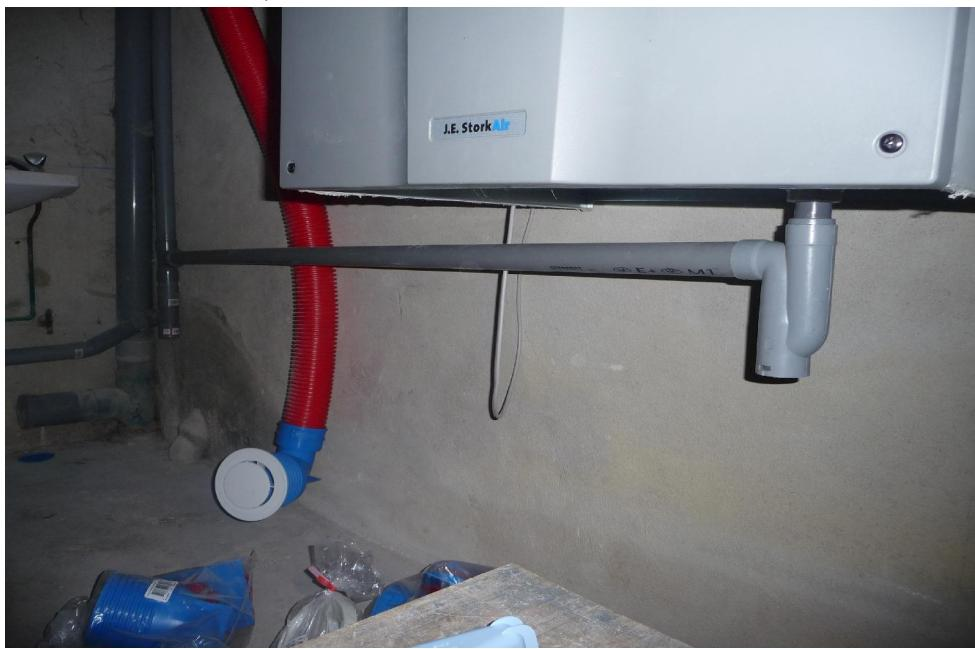
Sur le deuxième bloc, pas d'évacuation possible avant de casser la dalle béton, ce qui n'est pas prévu avant deux ans. Donc en provisoire, un bon siphon avec... un seau. Plusieurs litres par jour sorte depuis la mise en route (1 semaine).
