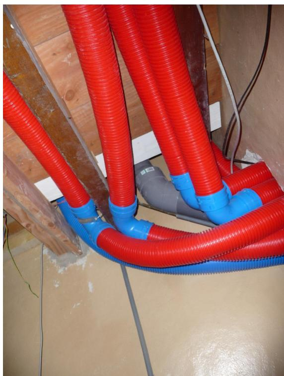
J'ai fait un plan détaillé de la maison, et où je voulais les bouches. Pour limiter les pertes de charges, le bruit et la consommation électrique, j'ai doublé le nombre de bouche généralement installée. J'ai par exemple trois arrivées dans la grande chambre (30m<sup>2</sup>), 5 dans le salon (40m<sup>2</sup> avec hauteur sous plafond d'environ 5,5m).
