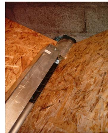
> Le silo doit être construit en fonction d'une épaisseur de mur allant de 15 à 20 cm. Il peut être construit en bois bien étayé rainuré.
