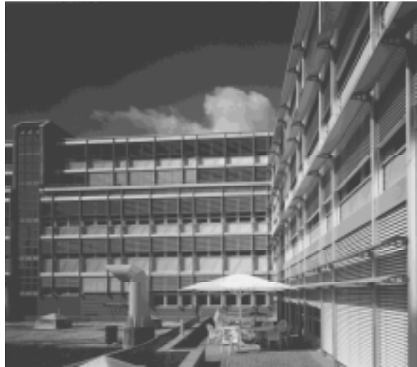
Gewerbehaus Schwerzenbacherhof, Schwerzenbach
