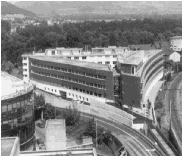
Bürogebäude Stahlrain, Brugg
