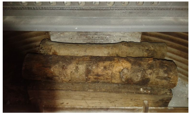
2/ Mise en place Niveau 2 en réduisant l'espaces interbûches
