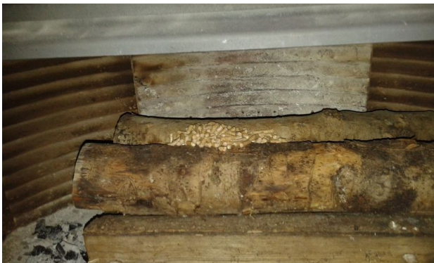
3/ Déposes des pellets au dessus de l'espace réduit
