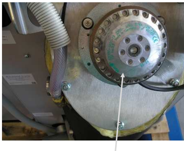
Ventilateur de fumées et arrivée du rinçage
