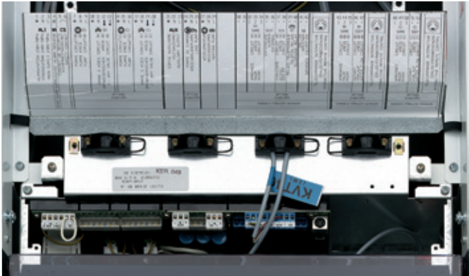
La vue ci-dessus montre le bornier de raccordement, capot de protection retiré.
