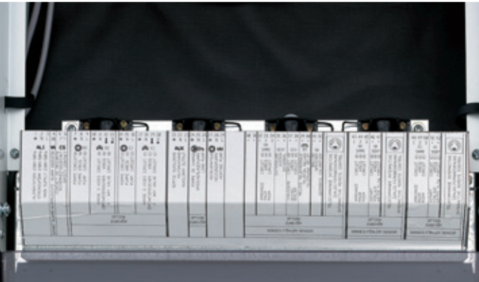
La vue ci-dessus représente la chaudière, vue de dessus, chapiteau retiré.
