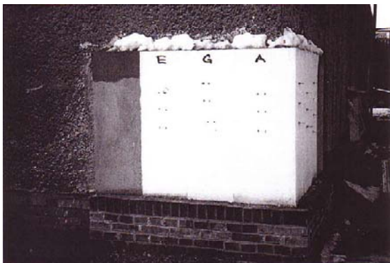
Le mur du côté sud recouvert de crépi
