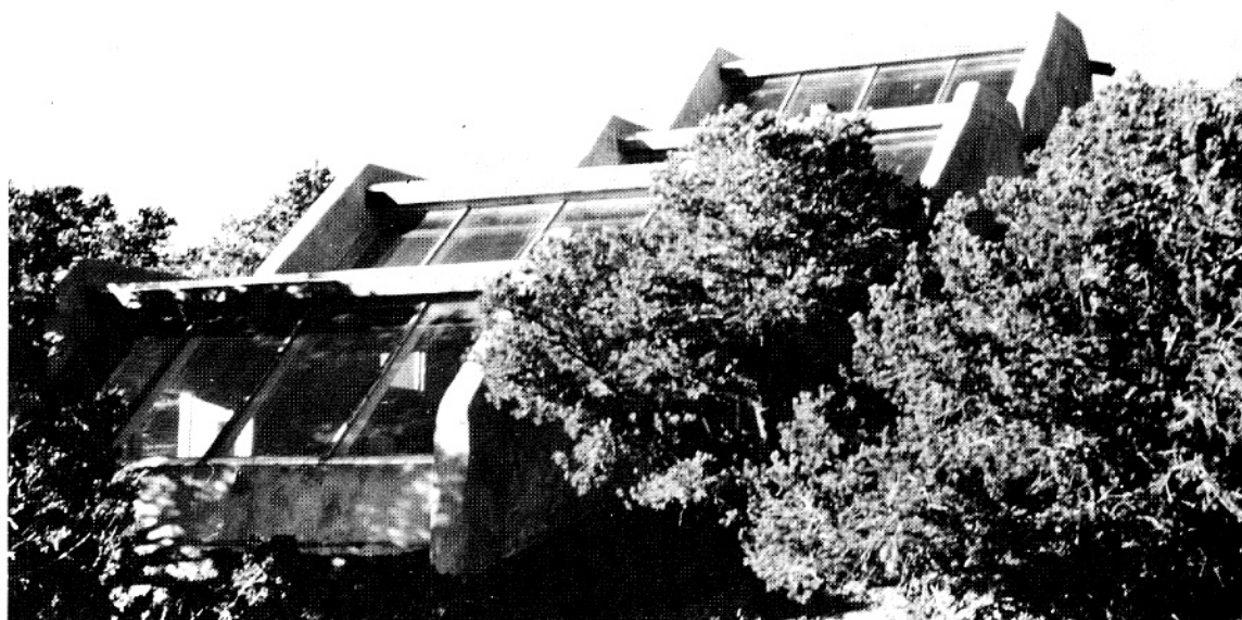
Photo III-4 La maison de Karen Terry - installée sur le versant sud, face aux apports solaires les plus forts en hiver.
