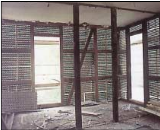
Rénovation des façades (colombages).
