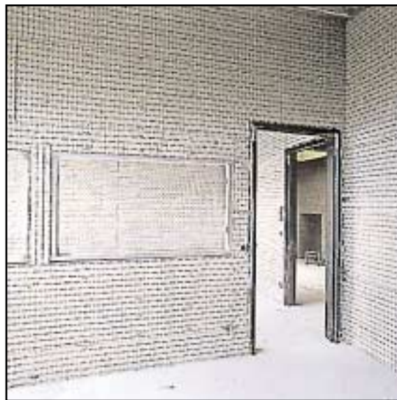
Des cloisons en Stucanet® Poutrafil®, hôpital St.-Jean (Bruges).
