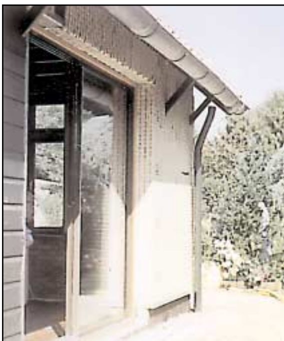
Rénovation d'une façade à Vledderveen, Drenthe (Neth.).
