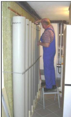
Pour un rendement encore meilleur, réalisez un caisson calorifugé de 100 mm autour des batteries et remplissez les interstices de gravillons.
