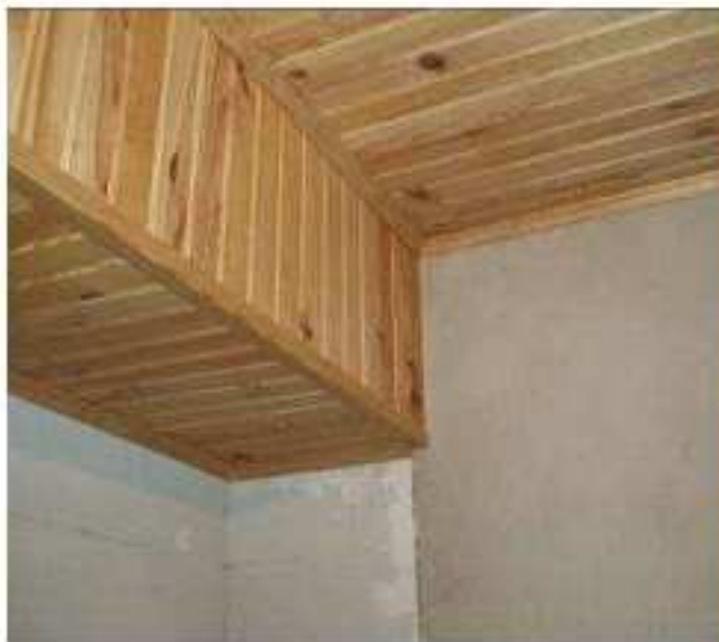
Angle à l'intérieur du débarras.
