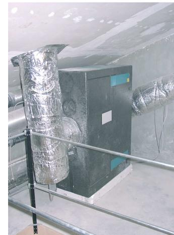
**Figure 10 :** Système de ventilation ayant un récupérateur de chaleur (rendement de 78%) et une faible consommation d'électricité – mesurés sur le terrain [2].
