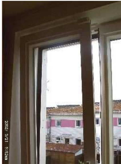
Figure 15 : Fenêtre inclinée pour la ventilation d'été.
