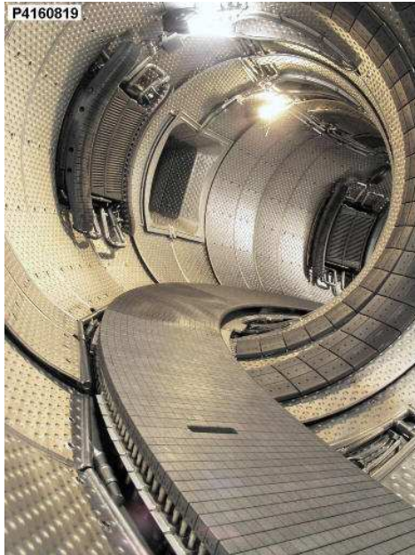
Chambre à vide de Tore Supra, avec, au premier plan, le « limiteur pompé toroïdal ». © P.Fiet/CEA
