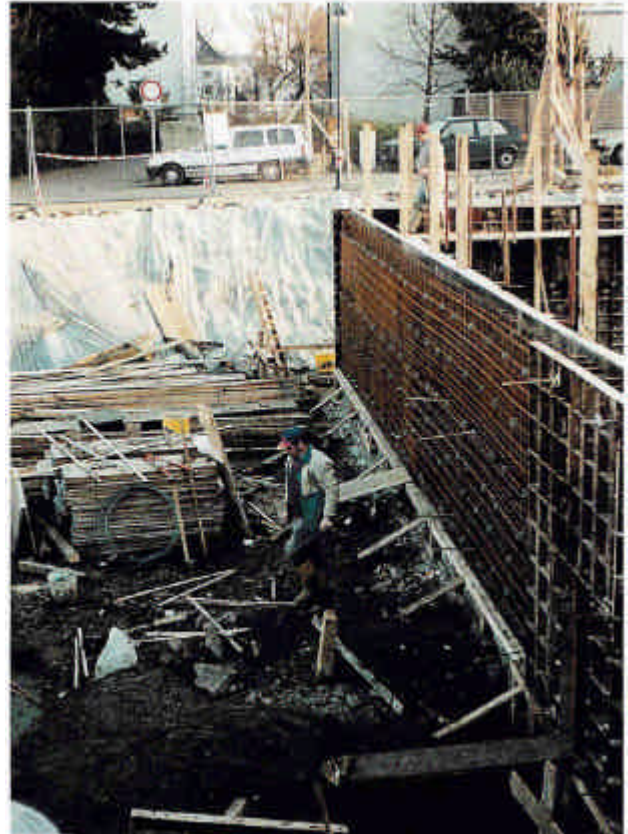
Treillis soudé pour murs de cave dans la construction de logements
