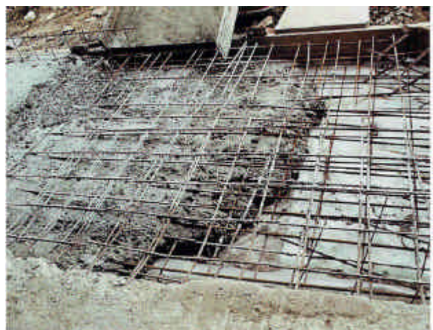
Treillis posé sur un sol de cave
