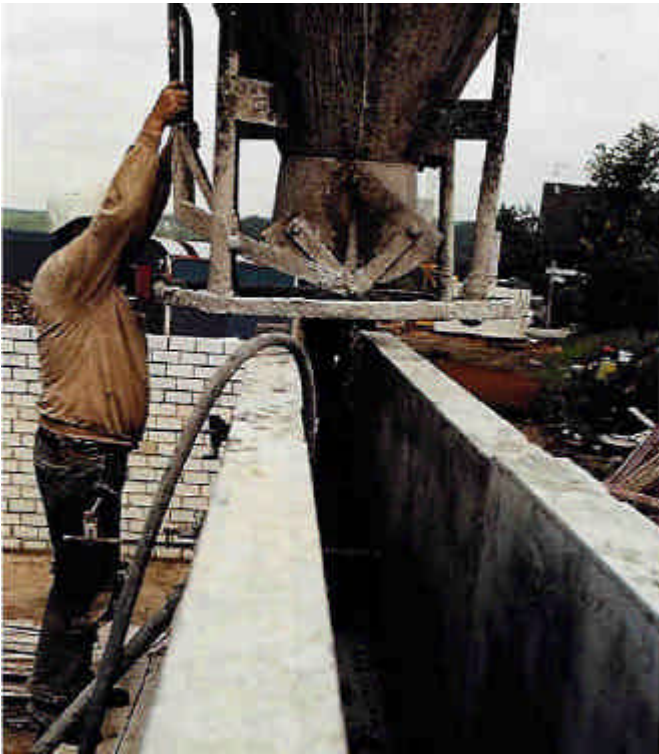
Coulage d'une dalle de cave avec du béton à fibres Fortius
