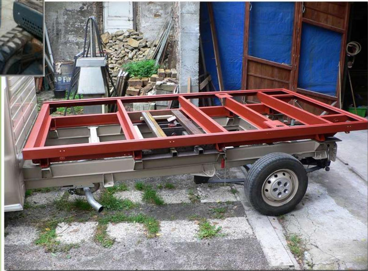
On peut ainsi procéder à la réalisation de la liaison plateau-vérin et effectuer le pré-montage de la pompe en vue des essais avant soudage définitif de tous les éléments.
