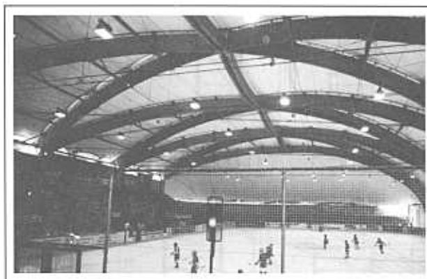
Figure 3.09.4 Structure porteuse en BLC recouverte d'une membrane textile (couverture d'un stade de glace)
